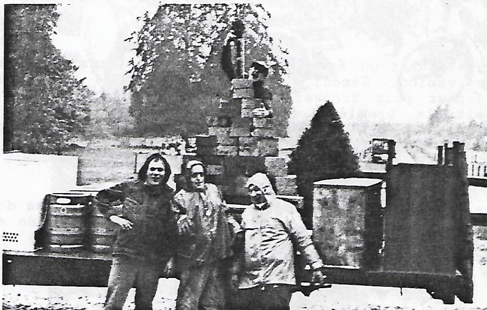
LUNDI: l'euphorie du démontage, sous la pluie!
